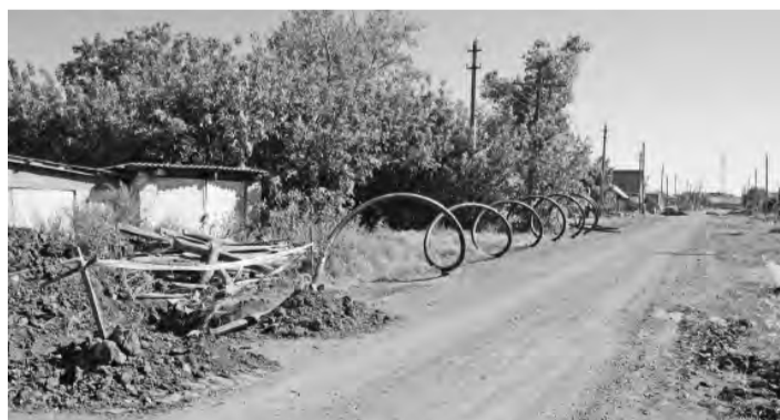
Газ тянут по улице Быковского
